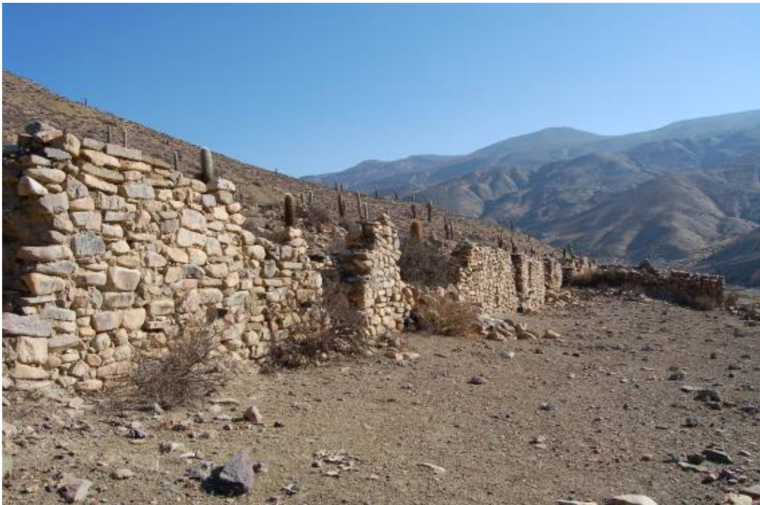
Foto 4: estructura rectangular alargada vista desde el norte.
