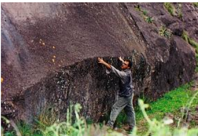
Fotografía N° 2: Detalle del corte en la roca sobre los acantilados.
