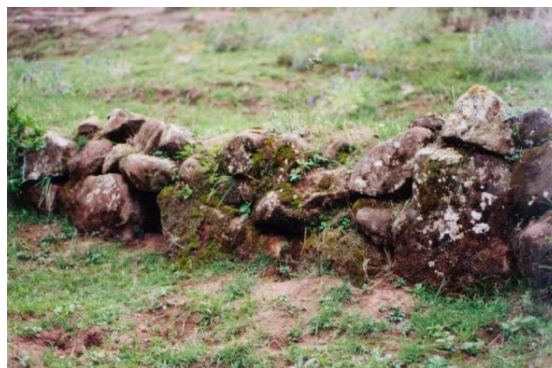
Fotografía N° 5: Alcantarilla interna que permite el desagüe del camino del Inka.
