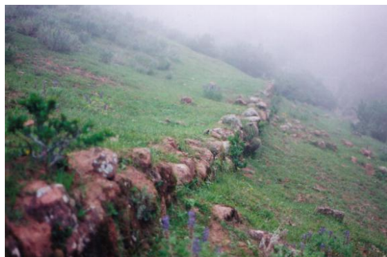
Fotografía N° 4: Camino Inka en La Quesera, de tipo con talud en pendiente lateral suave
